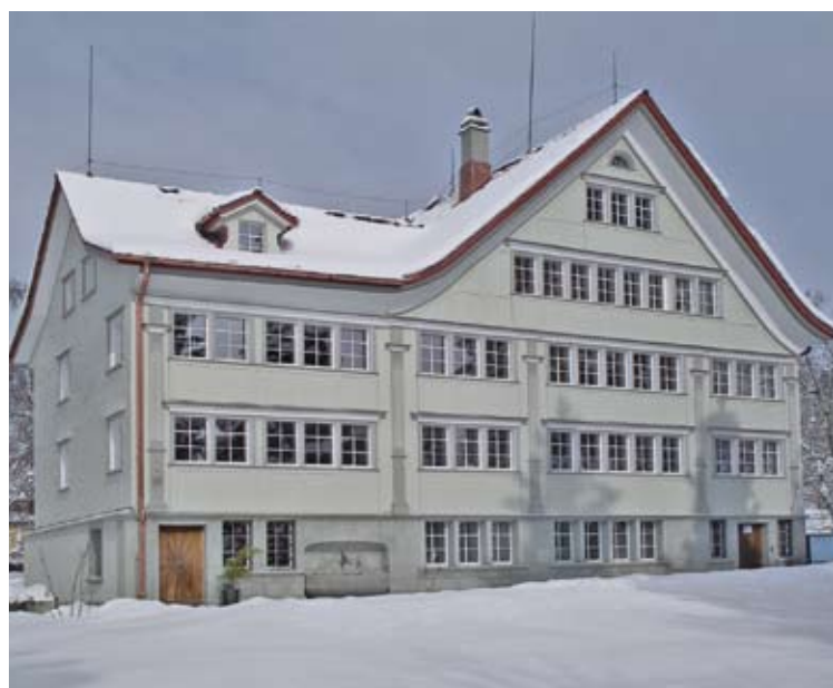
Aussenansicht des restaurierten Pfarrhauses Hörli. Foto: pg.
